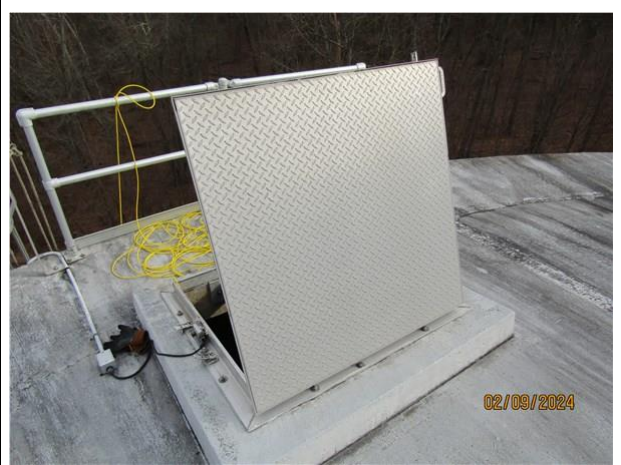
23) Bilco style roof hatch
