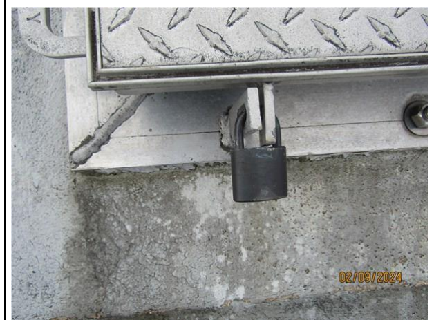
30) Locked roof hatch
