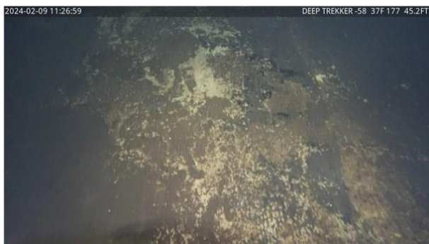
51) 22:54 - Intact floor below the sediment layer
