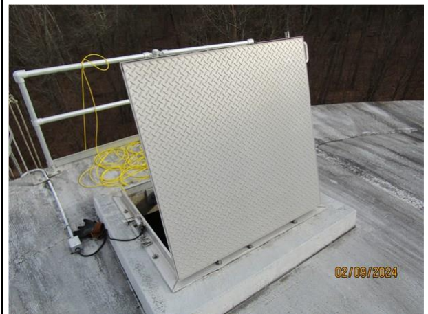
23) Bilco style roof hatch
